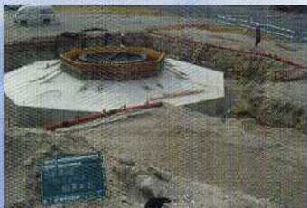
基礎のコンクリート打設完了。ここまでは土木工事の技術がベース。
