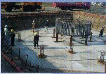
タワーと接地するアンカーボルト工事
