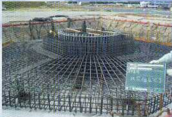
基礎の鉄筋工事
